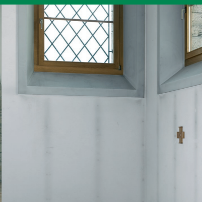
Condensvorming op koudebruggen preventief behandelen om het risico op plaatselijke vuilafzetting (vb. aftekening van het onderliggende aluminium raamwerk) te beperken.
