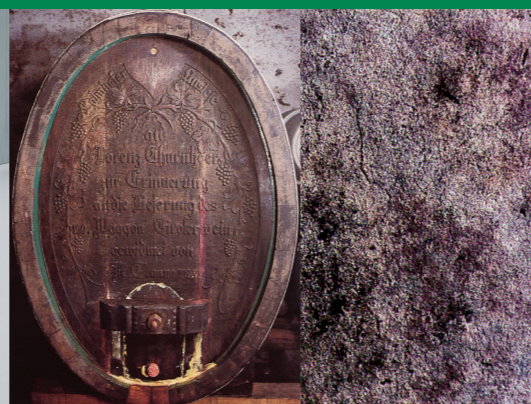
Moisissures dans une cave à vin.
