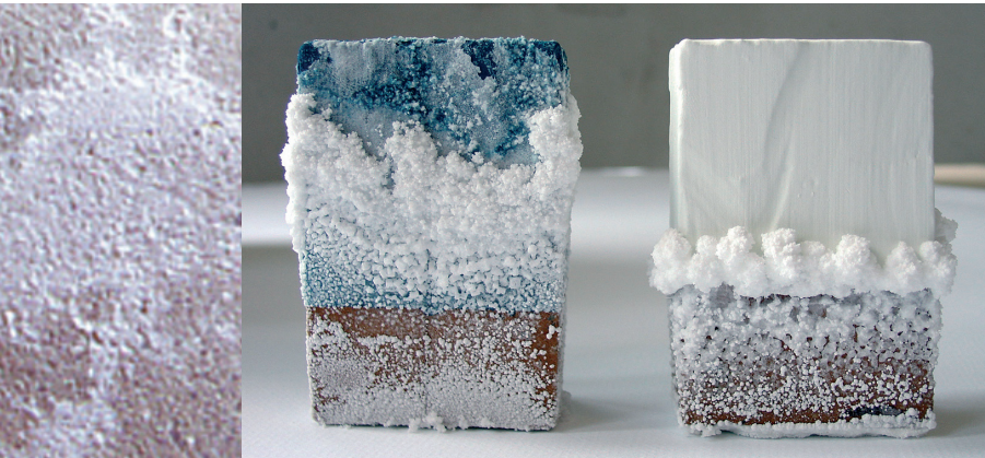
Efflorescences dues au développement de salpêtre
