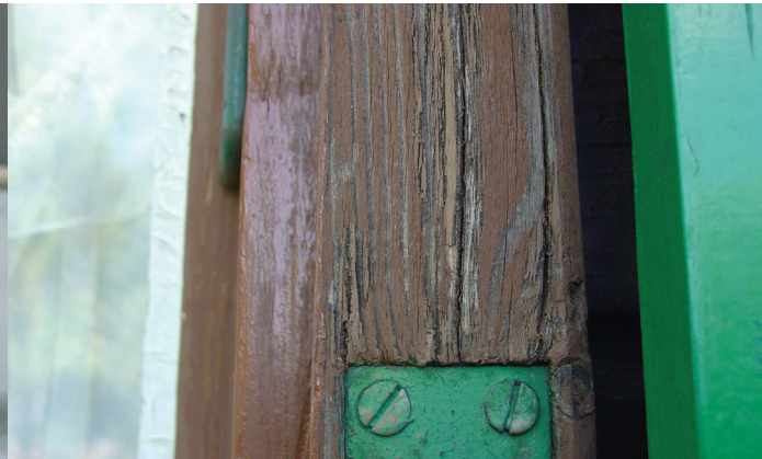
Consolidation d'un support en bois
