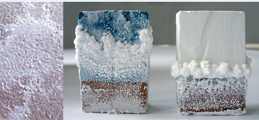
Ausblühungen aufgrund von Salpeterbildung
